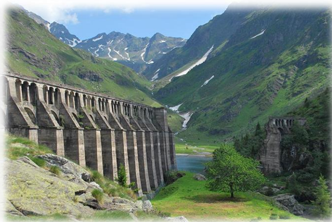
Diga del Gleno (m.1527)
